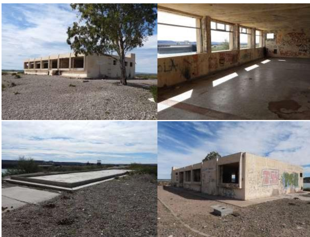
Fotografía 23. Edificio destinado al personal y a como centro de informes / interpretación.
