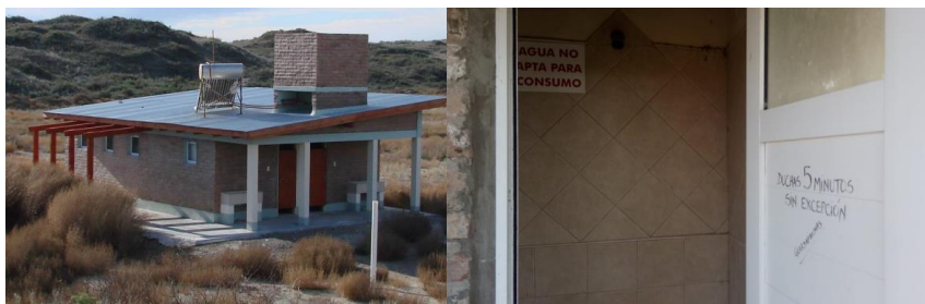
Fotografía 60. Instalaciones sanitarias en 2009.
