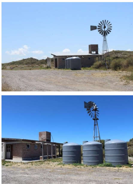
Fotografía 59. Instalaciones sanitarias desde el sector del área de acampe y tanques de agua para su suministro.
