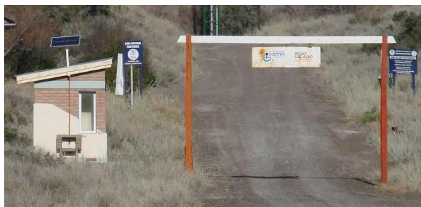
Fotografía 56. Ingreso a Pozo Salado 2009.
