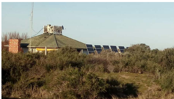
Fotografía 67. Instalación de paneles fotovoltaicos delante la vivienda de los guarda ambientales.
