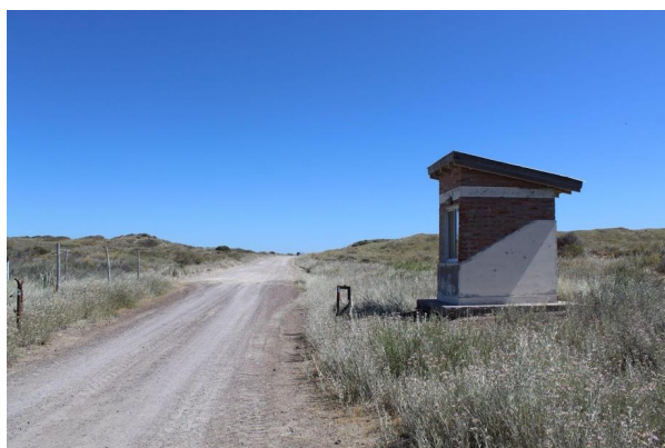
Fotografía 57. Ingreso Pozo Salado 2022.
