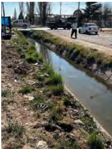
A esta altura el canal de riego se encuentra revestido
