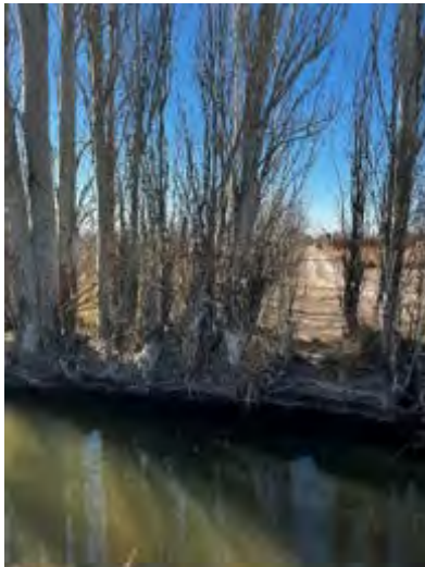
Canal de riego sin revestir. Álamos de una vieja barrera contra el viento que deberán ser removidos si el canal se reviste.
